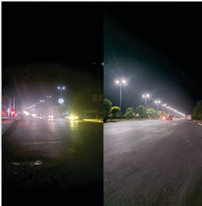
چراغ ال ای دی ۶۰ وات ( بعد از تعویض ) چراغ ۲۵۰ وات بخار جیوه ( قبل از تعویض )
